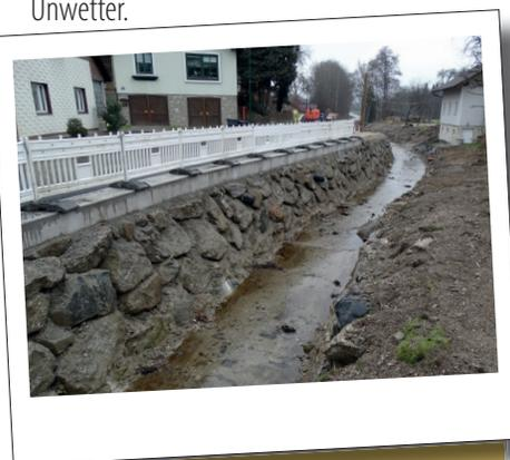
Ströblitz: Grobsteinschichtungen, Ufersicherungen und Gerinneausbau entlang des Baches
