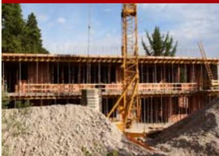
Weitere Bauarbeiten: Das Obergeschoß ist hochgezogen und die Decke betoniert.
