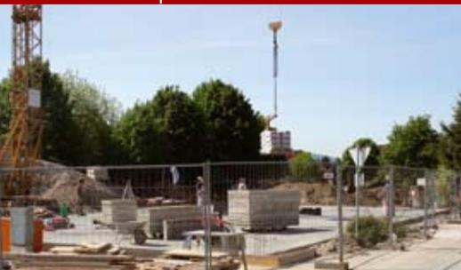
Die Firma Schweighofer Bau GmbH wurde mit den Baumeisterarbeiten beauftragt. Die Sohle ist bereits betoniert und die ersten Baustofflieferungen werden entgegengenommen.
