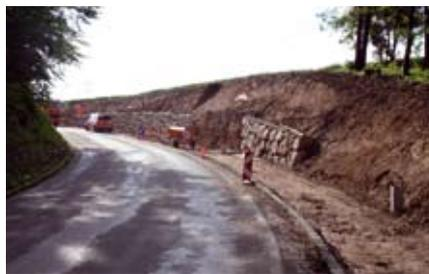
Bei der Errichtung des Gehsteiges bzw. Radweges vom Sportplatz in Richtung Berging werden 500 Tonnen Wurfsteine für die Natursteinmauer verlegt. Die Kurve im Kreuzungsbereich wird ausgebaut und dadurch entschärft.
