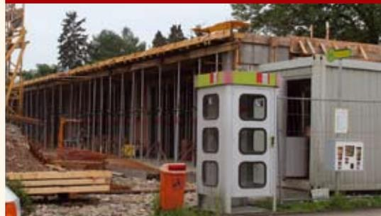
Die Bauarbeiten verlaufen nach Plan. Die Schalung der Decke ist fertig, alle Fertigteilelemente sind verlegt. Es kann betoniert werden.
